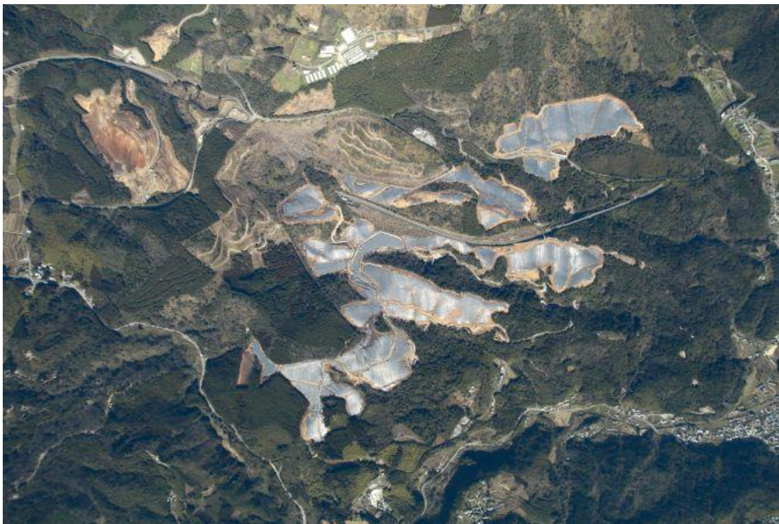
図表 5. CS 日出町第二発電所 (大分県) (54MW)
